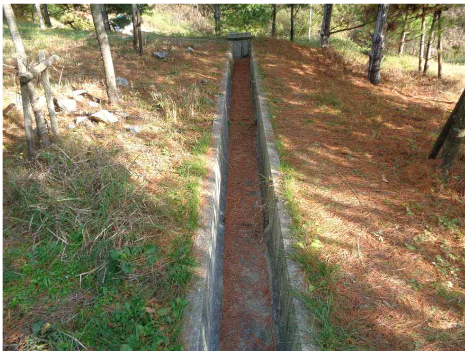
사면 배수로 전경
