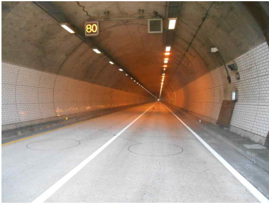
터널 내부 전경
